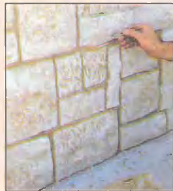
Чтобы раствор в швах примыкал к камню, его разглаживают влажной кистью.
