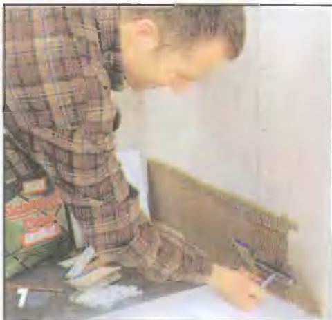
Клей для керамической плитки наносят на стену зубчатой кельмой ниже размеченной линии.
