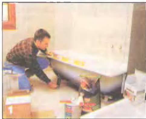
Устройство ванной начинают с составления детальной планировки, рациональность которой можно проверить, временно разместив в соответствии с этой планировкой сантехническое оборудование.
