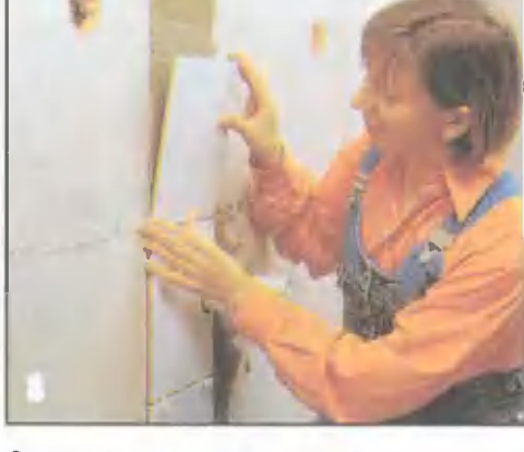
Снизу вверх укладывают плитки среднего ряда. Шовные крестовины обеспечивают одинаковую ширину швов и их правильное расположение относительно друг друга.
