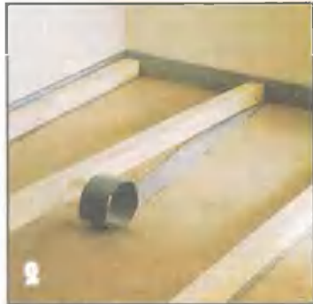
2 Лаги под новое напольное покрытие укладывают на войлочные полосы (или полосы из мягких ДВП).
