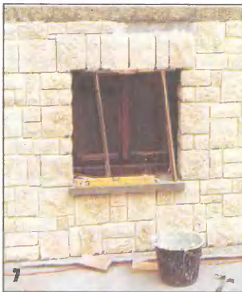
При облицовке перемычки над оконным проемом следует обратить внимание на симметричность кладки — левая и правая части перемычки должны быть уложены зеркально от середины проема. Уложенные камни поддерживает доска, подпертая двумя отрезками брусков.
