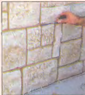
Швы расшивают за один прием на участках площадью в 1 м². Возможные наплывы разглаживают металлической расшивкой, равномерно смещая слегка подсохший раствор к краям.
