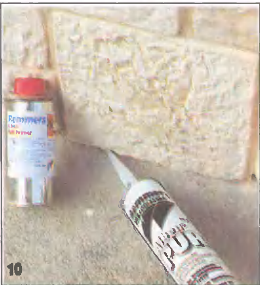
10 Нижний шов заделывают эластичным герметиком, что исключает передачу на облицовку нагрузок от температурных деформаций тротуарного покрытия или отмостки.
