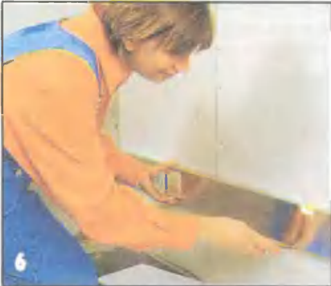
Облицовку кафелем начинают со стен. Здесь показана разметка с помощью длинного уровня первого ряда плиток.
