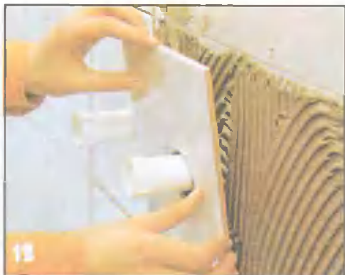
Труба проходит сквозь облицовку в круглое отверстие. Пластиковая пробка защищает резьбу трубы от возможных повреждений.
