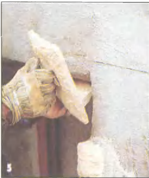
У перемычек по краям кладут большие угловые камни, горизонтальную полку которых обламывают сбоку,...
