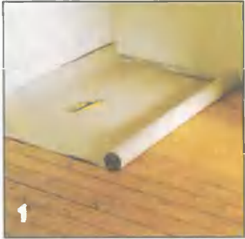
1 Старый дощатый пол укрывают плотной (упаковочной) бумагой, чтобы керамзит не просыпался на промежуточное перекрытие.
