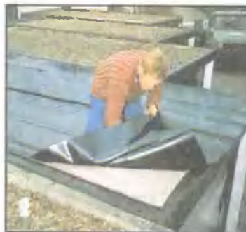
Корнезащитная пленка препятствует внедрению корней растений в крышу. Она свободно свисает, пока не будет закончена полная укладка кровли.
