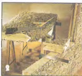
2 При установке у скошенного потолка (здесь — под углом 45°) элементы раскраивают ножовкой по дереву и крепят к стене и каркасу.
