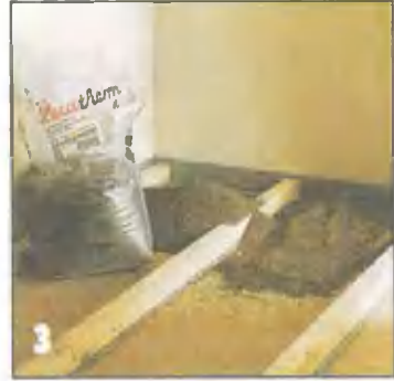
3 Между лагами отсыплют керамзит, препятствующий возникновению резонанса старого дощатого настила.
