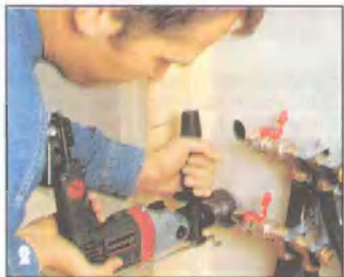
Трубы монтируют, пока стены еще открыты, хотя бы с одной стороны. На фото показан вырез отверстия для трубы.
