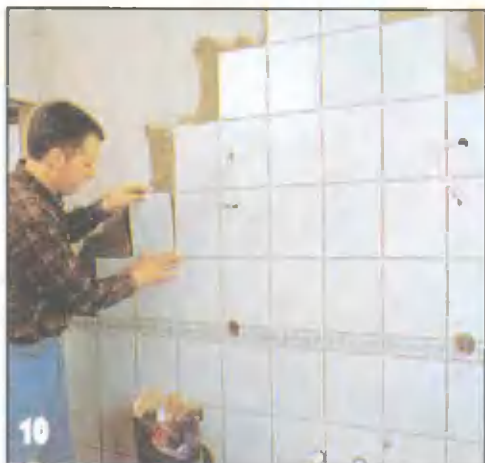
Постепенно стена приобретает законченный вид. Расположенный на высоте 1 м бордюр украшает и зрительно удлиняет стену.
