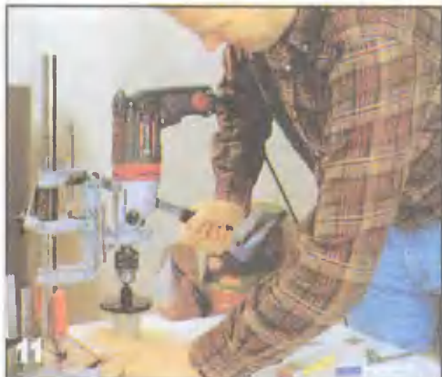
Твердосплавной кольцевой пилой, установленной в закрепленную на сверлильной стойке электродрель, в плитке нетрудно вырезать отверстие под трубу.
