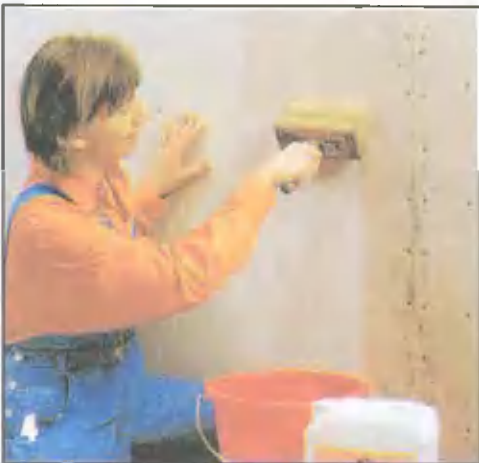
Грунтование обшивки стен из гипсоволокнистых плит перед их оклейкой обоями и облицовкой керамической плиткой.
