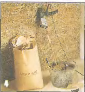
4 Стену из саманных элементов оштукатуривают раствором из разведенной в воде глины, нанося его слоем толщиной 2 см в два-четыре приема.
