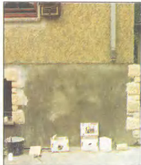
Здесь еще раз показано начало работы. Первые угловые камни совпадают по уровню, чтобы при последующей облицовке поверхности...
