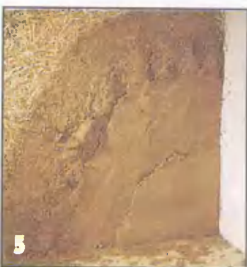
5 Сначала влажный глиняный раствор втирают руками в саманную набивку. Затем наносят основной и отделочный слой.
