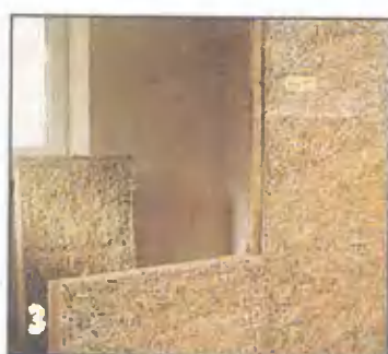
3 Каждый ряд элементов дополнительно усиливают вертикальным брусом, прикрепленным к полу и потолку. Так постепенно, сегмент за сегментом, возводят всю стену.
