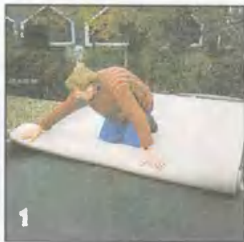
По старой кровле расстилают специальный защитный холст шириной 200 см, который защищает корнезащитную пленку.
