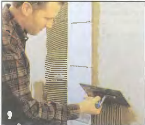
После укладки среднего ряда наносят клей на прилегающие к нему с двух сторон зоны, чтобы начать формировать облицовку в виде пирамиды.
