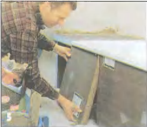
Заготовками из облицованных с одной стороны (и пригодных для отделки кафелем) плит из пеноматериала зашивают ванну.
