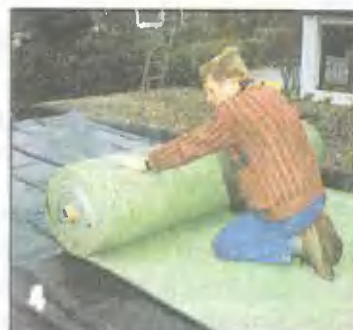
Расстилают на крыше дренажный мат шириной 200 см. Мелкие дренажные каналы расположены снизу, что обеспечивает сток воды.
